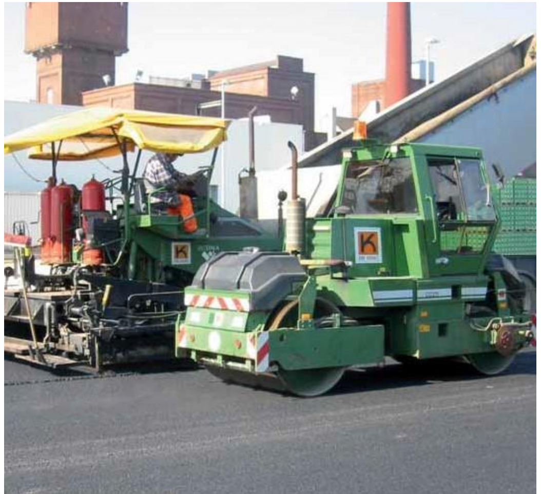
Straßensanierungen in Industrieparks gehört zum Geschäft der Gebr. Kickartz.
